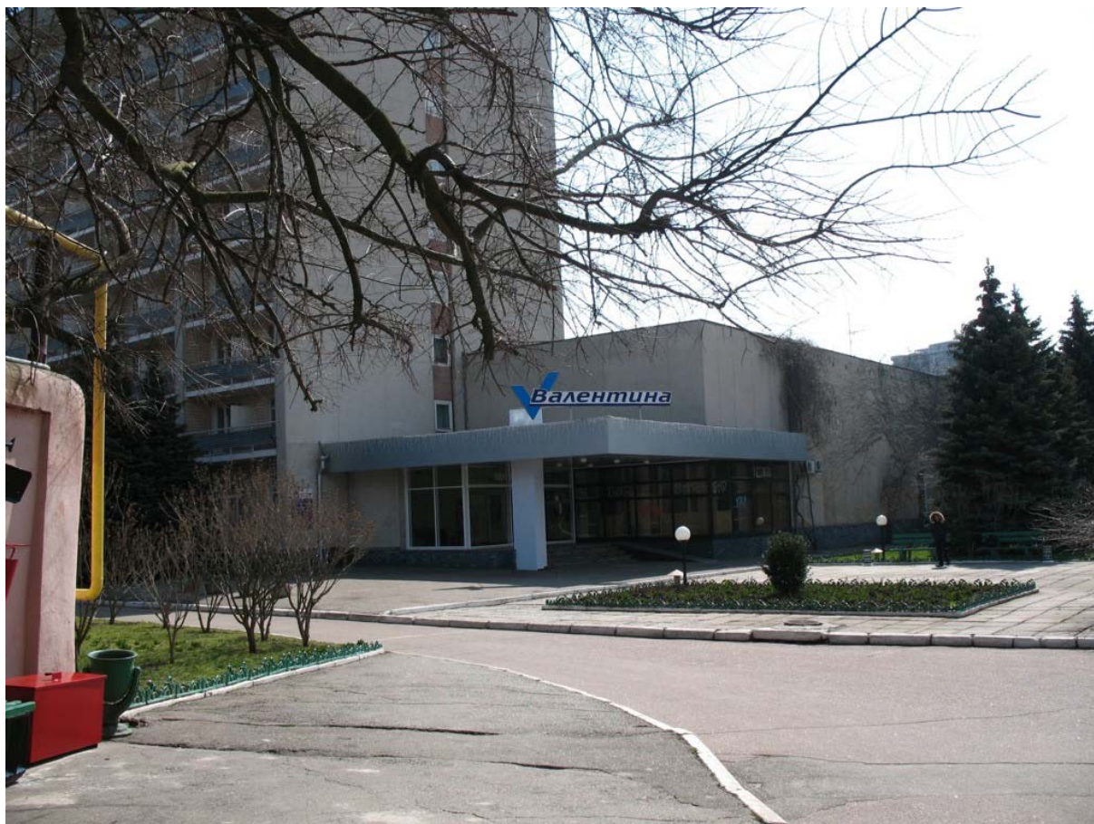
Вид с проходной (территория гостиницы огорожена) на вход в здание гостиницы.
